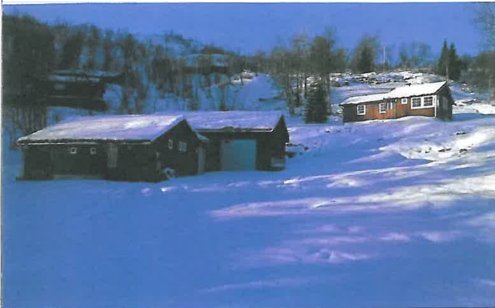
Bygg for gammalt vassverk til venstre, mellombygg og nybygg.
